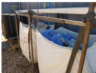
Dispositif de tri sélectif sur un chantier (Photo Naturalia)
